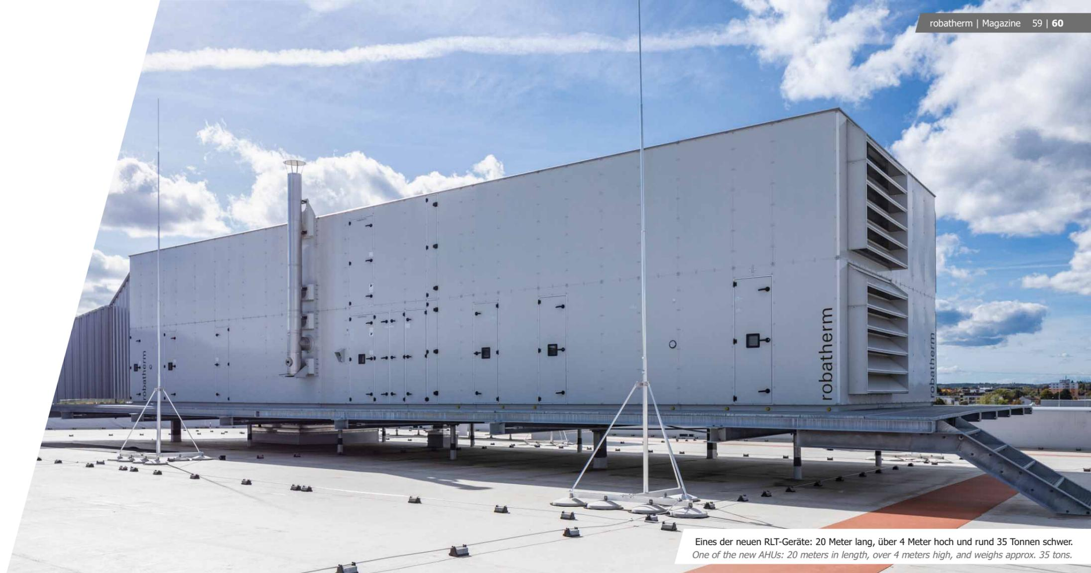
Eines der neuen RLT-Geräte: 20 Meter lang, über 4 Meter hoch und rund 35 Tonnen schwer.
