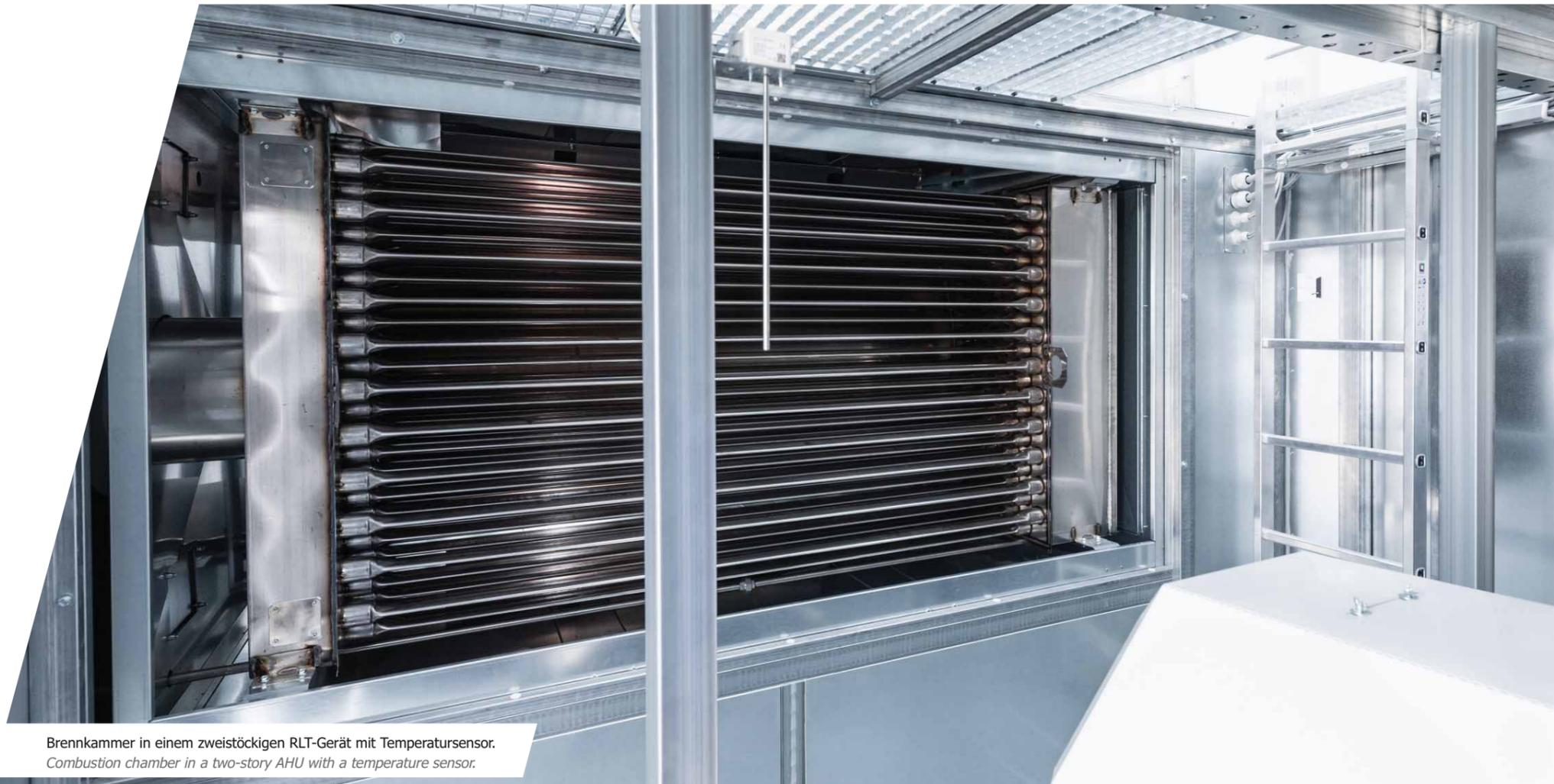
Brennkammer in einem zweistöckigen RLT-Gerät mit Temperatursensor.
