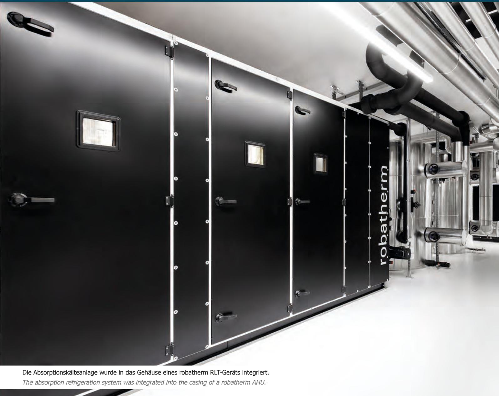
Die Absorptionskälteanlage wurde in das Gehäuse eines robatherm RLT-Geräts integriert.
