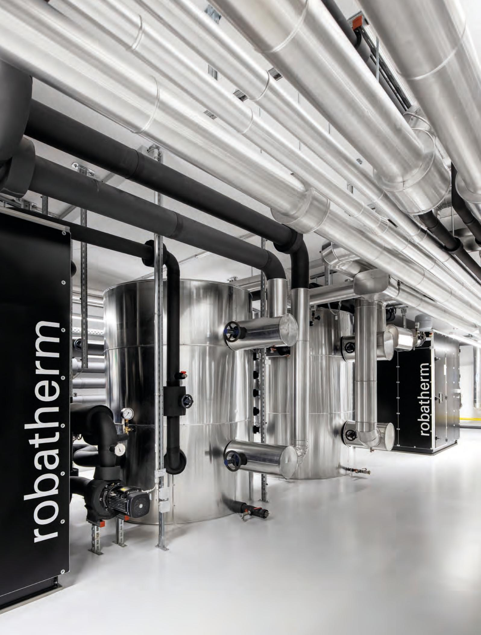
Der Niedertemperatur- und der Kaltwasserpufferspeicher.
