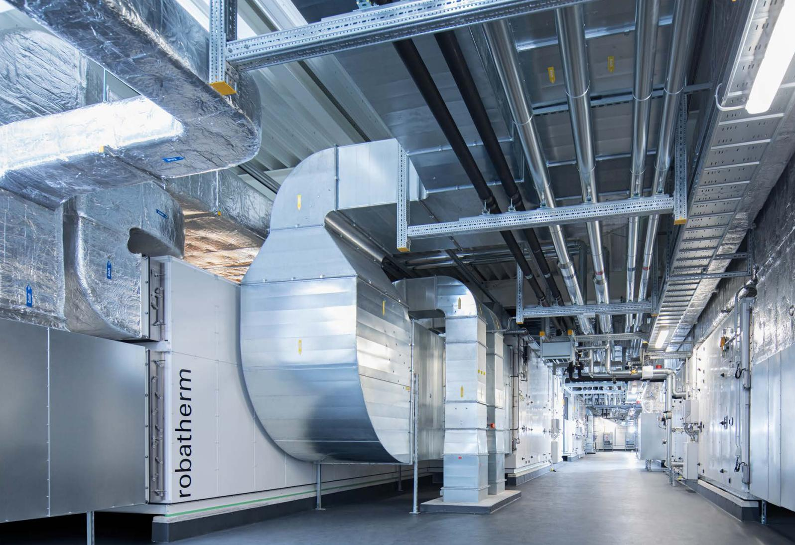
Raumluftechnik bedeutet Verantwortung. Diese RLT-Geräte klimatisieren einen Reinraum für die Produktion von Satelliten.
